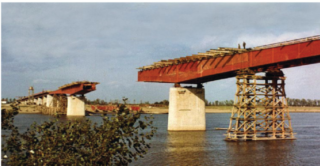
Слика 6. Друмски мост њреко реке Саве
